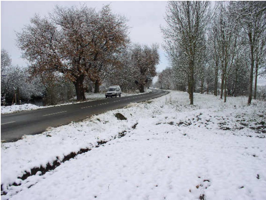
Una carretera local atraviesa Los Arbolicos de Lopidana.
