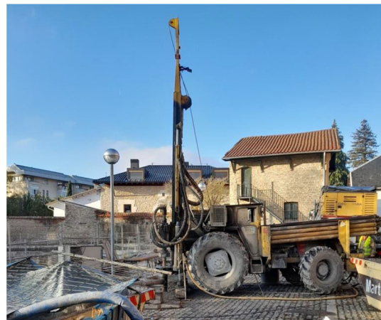
Perforación de sondeos
