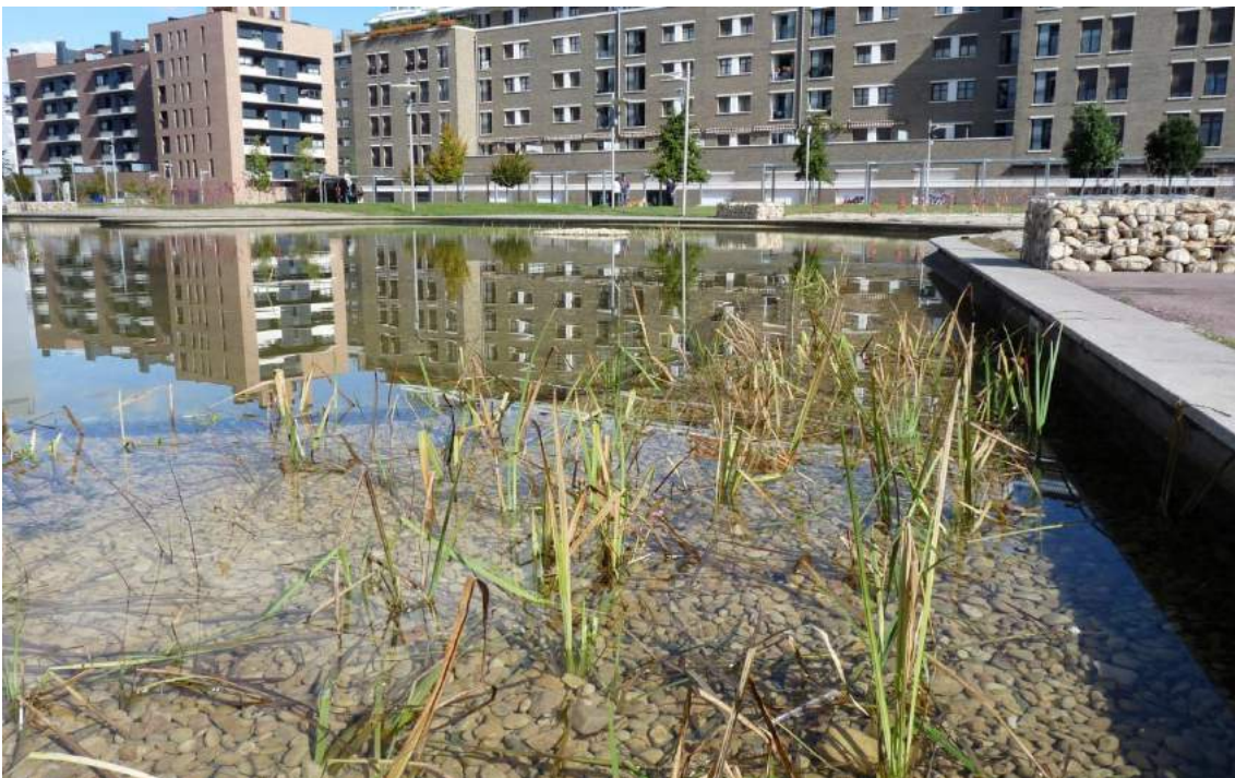
Vista parcial del estanque del parque del Este tras las obras de naturalización (Luis Lobo)
