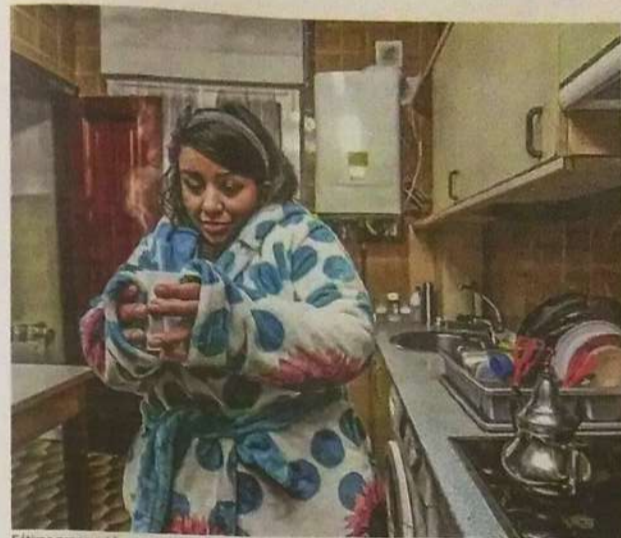
Fátima prepara té en su cocina, donde está instalada la caldera de gas que no puede ni enchufar.
