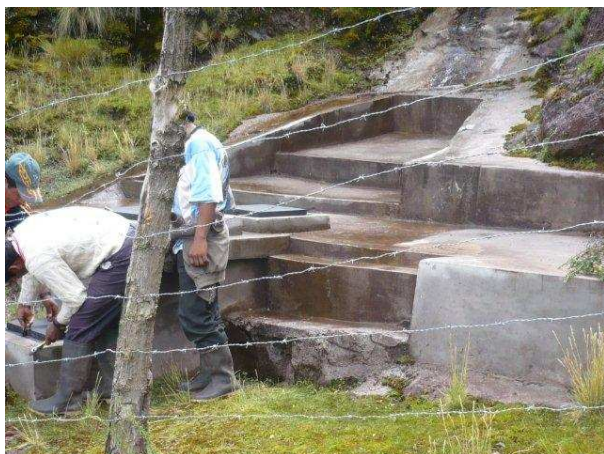
Captación SER en Jatumpampa 2005
