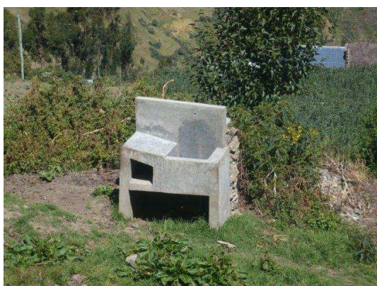
Lavadero proyecto PRONASAR. Cosme que todavía no está en funcionamiento
