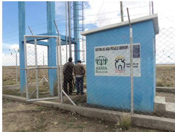
Fotografía N° 01: Caseta de bombeo construida
