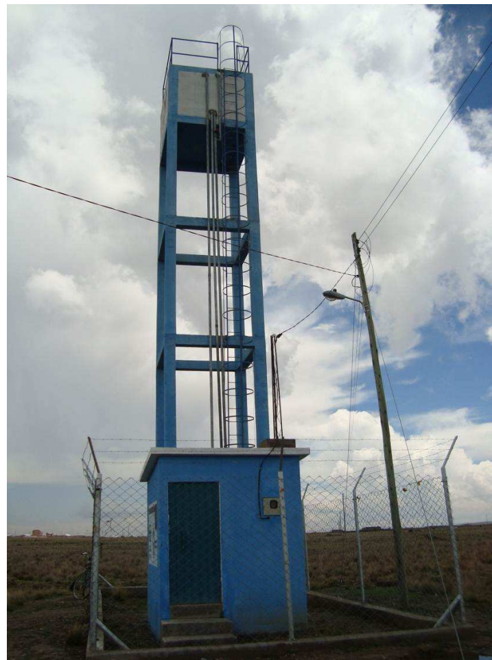
Fotografía N° 07: Tanque elevado construido
