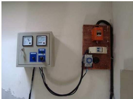
Fotografía N° 05: Tablero de control eléctrico con cables expuestos al aire libre y sin protección.
