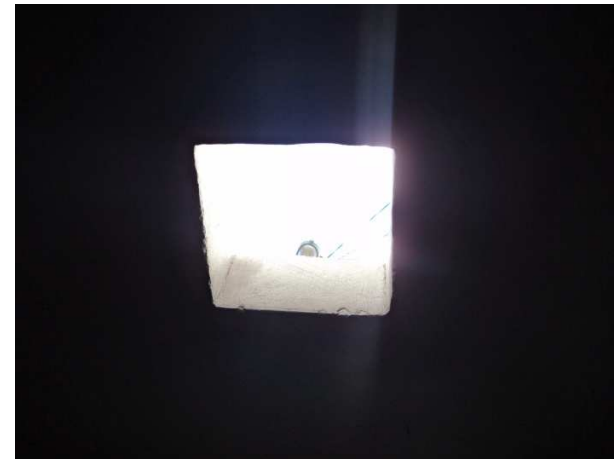
Fotografía N° 04: La ventana en el techo dimensión reducida para maniobrar la tubería de impulsión y desmontaje de la bomba.
