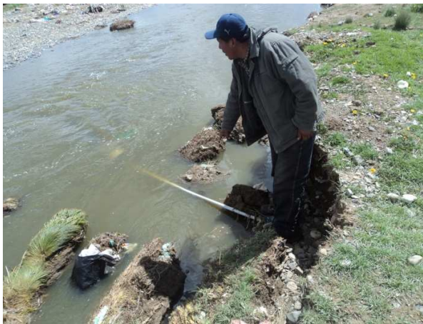
Fotografía N° 06: Tubería instalada que cruza en cause de un río (en la carpeta del proyecto estaba considerado la construcción de un pase aéreo).
