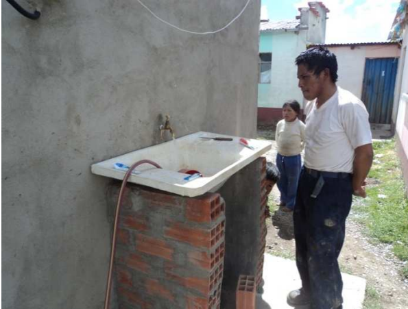
Fotografía N° 05: Lavandería domiciliaria construida
