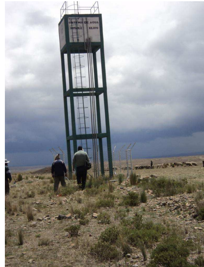
Fotografía N° 07: Tanque elevado construido
