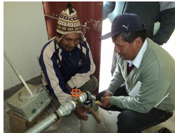
Fotografía N° 02: Verificando el nivel estático del agua y la profundidad del pozo.
