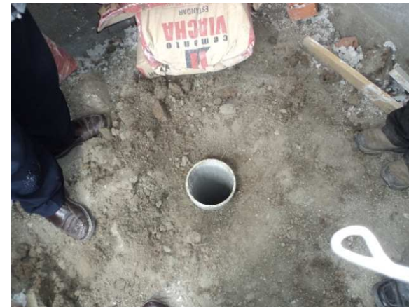
Fotografía N° 03: Extremo superior descubierto de la tubería de pozo
