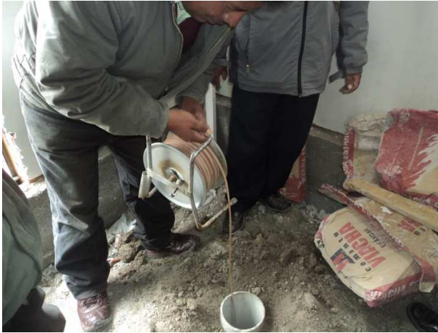
Fotografía Nº 04: Verificando el nivel estático del agua y la profundidad del pozo.
