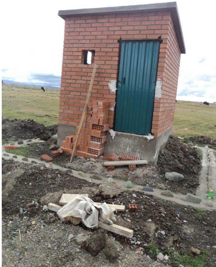
Fotografía N° 01: Caseta de bombeo en construcción
