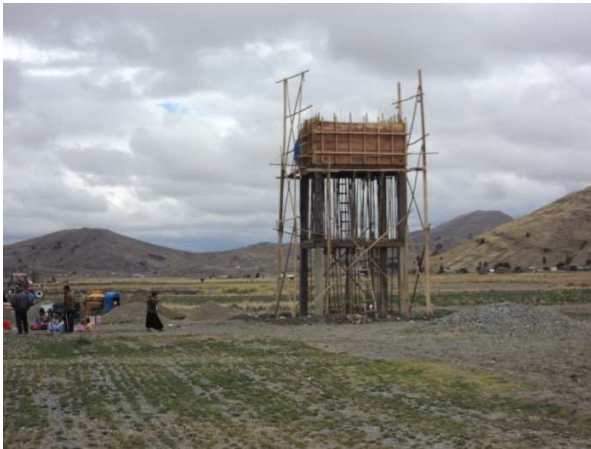
Fotografía Nº 06: Caseta de bombeo en construcción
