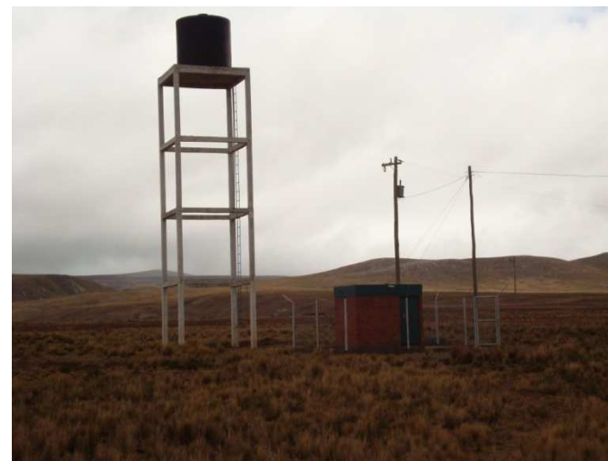
Fotografía N° 05: Tanque elevado existente en funcionamiento
