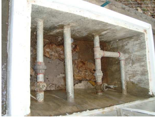
Fotografía N° 07: Caseta de Válvulas del reservorio
