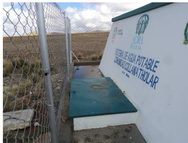
Fotografía N° 06: Reservorio rehabilitado y/o mejorado
