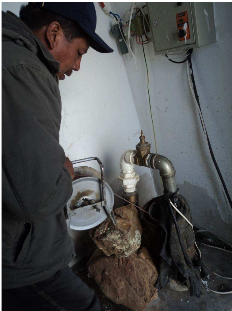
Fotografía N° 04: Verificando el nivel estático del agua y la profundidad del pozo.
