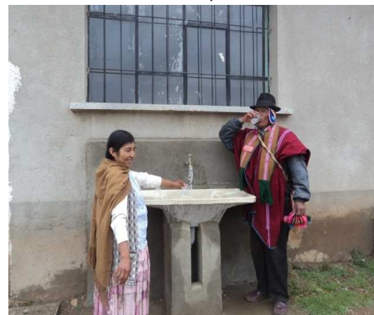
Fotografía N° 07: Lavandería domiciliaria construida
