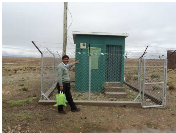
Fotografía N° 02: Caseta de bombeo construida
