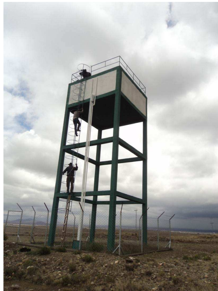
Fotografía N° 09: Tanque elevado construido
