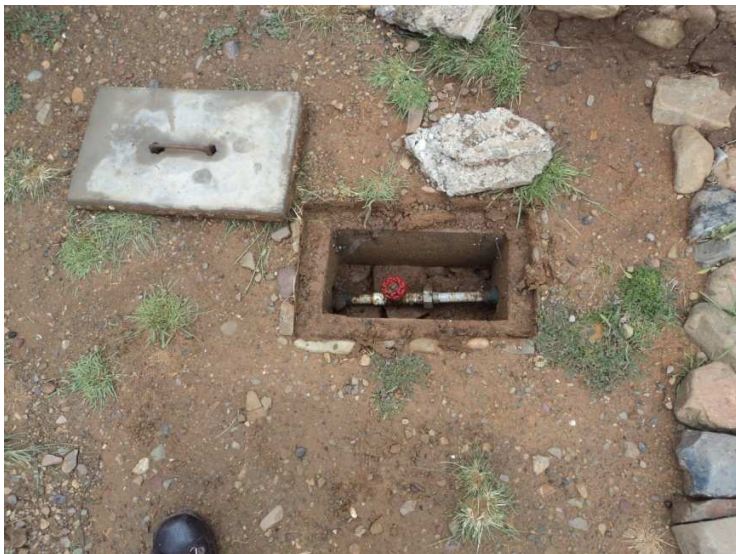
Fotografía N° 08: Válvula de control domiciliario instalada con una unión universal
