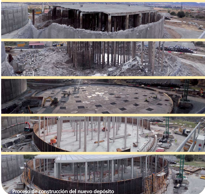
Proceso de construcción del nuevo depósito
