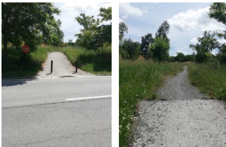
Ilustración 29. Estado actual del acceso a Jundiz por Zuazo
