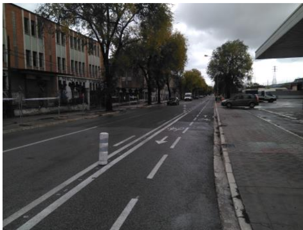
Ilustración 9. Carril bici en la calle Artapadura
