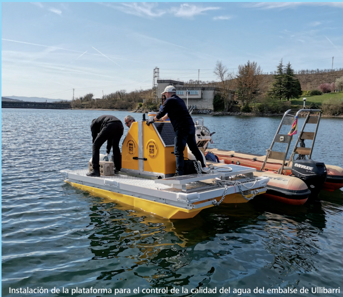
Instalación de la plataforma para el control de la calidad del agua del embalse de Ullibarri
