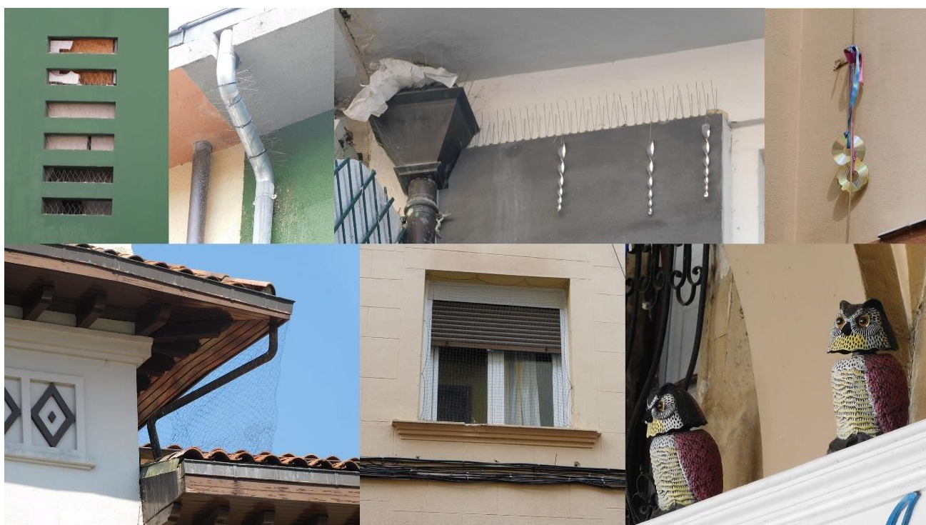
Figura 7. Diferentes tipos de elementos para disuadir a las aves (defensas antipájaro) encontradas durante las descripciones de las características de los edificios. Se muestran pinchos, elementos iridiscentes (CDs, cintas), mallas metálicas y señuelos de rapaces (búhos).
